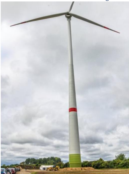
Das höchste, stärkste und vielleicht letzte Windrad Berlins: Eine Anlage vom Typ Enercon 138 auf einem Pankower Acker sollte die Windkraftproduktion Berlins um 30 Prozent steigern. Rotoren kreisen bis in 230 Meter Höhe.
